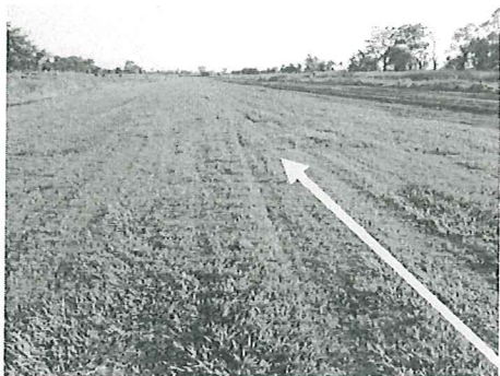
Rastro dejado por la aeronave y la hélice sobre la superficie de la pista
